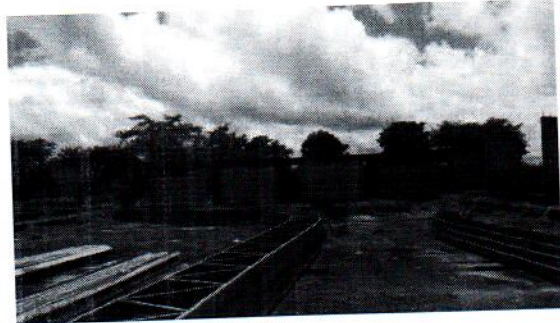
Foto 16 e 17 – Arcos metálicos armazenados de forma irregular
